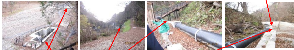
曲り部は水撃に対し コンクリート補強
