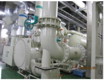
高効率 (インバーター) 電動ターボ冷凍機
