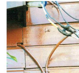
▲電線をひきこむあなから空気もれていることがある。すきまをふさぐ材をつめてすきま風をなくす。
