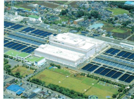
▲浄水場。砂や土をとりのぞくためのプールがたくさんある(埼玉県朝霞浄水場)。
