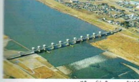
▲川の水をとりいれる堰(群馬県と埼玉県の間境の利根大堰)。
